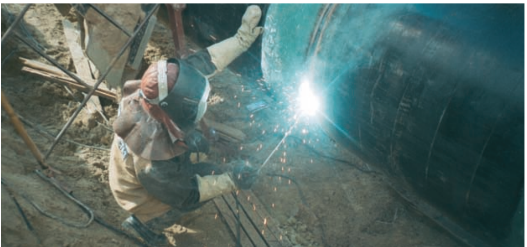
↑ «Врезка» МГ 0-34 «НВ ГПЗ - Парабель» велась одновременно на шести участках магистрали
